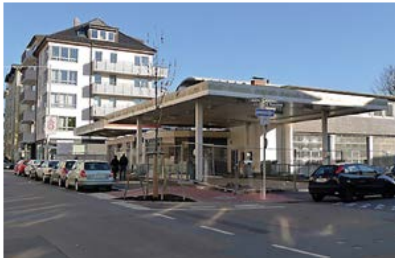
Vorher: Ursprungszustand Tankstellennutzung ↓
