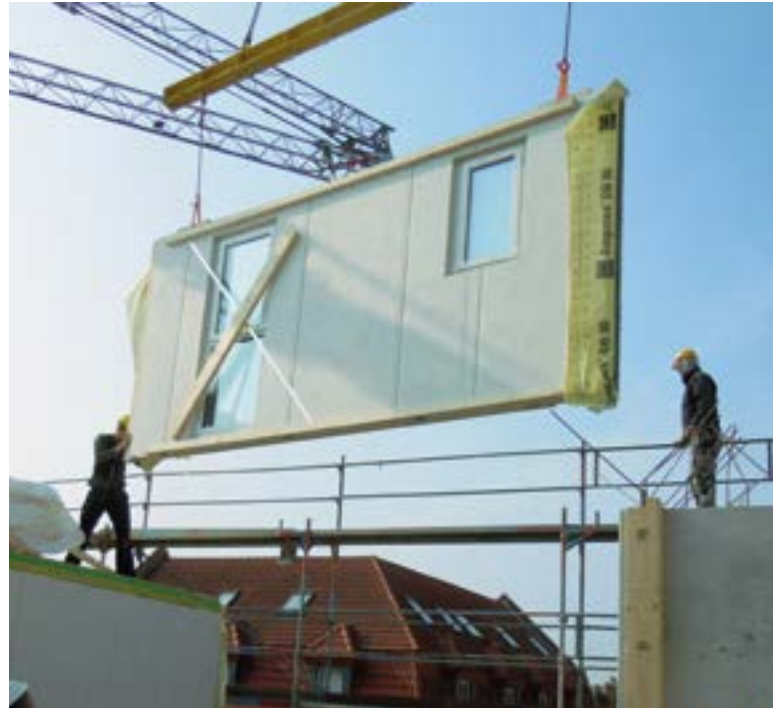
Montage der vorgefertigten Fassadenmodule ↑
