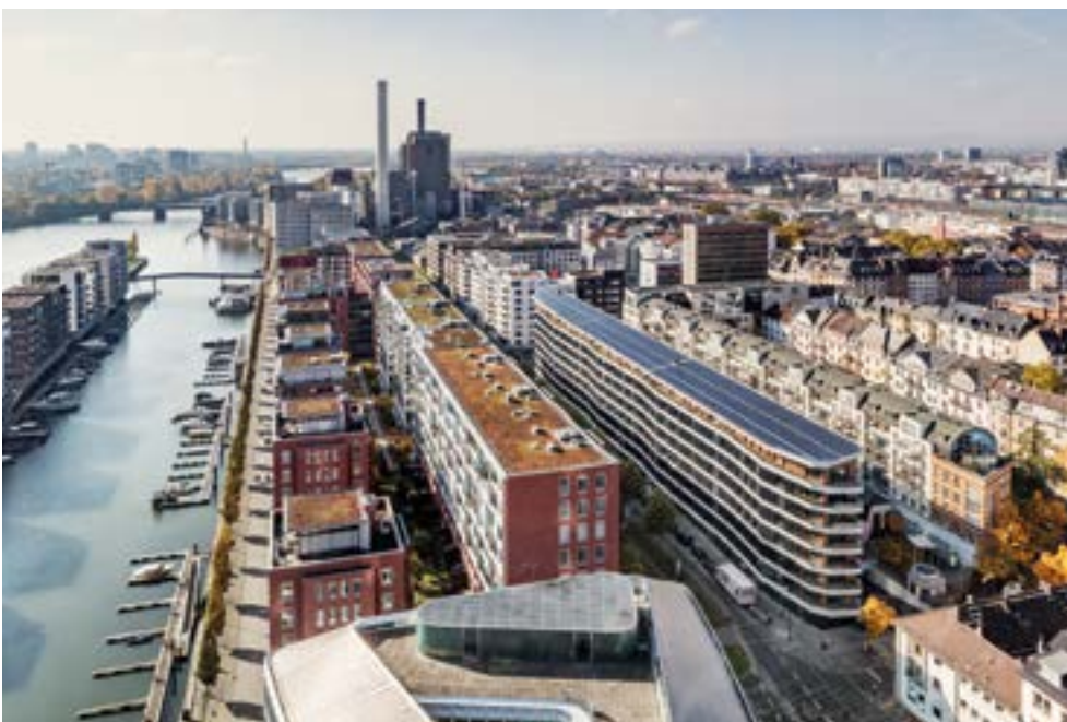
Das große Pultdach als Energiequelle ↓
