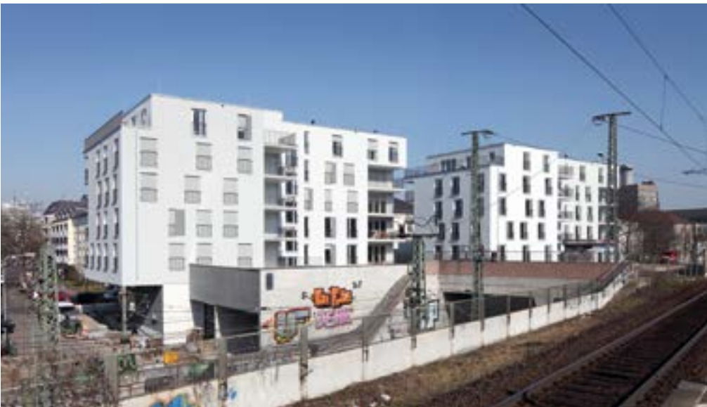
Südseite mit Garagenzufahrt und S-Bahn-Tunnel ↑
