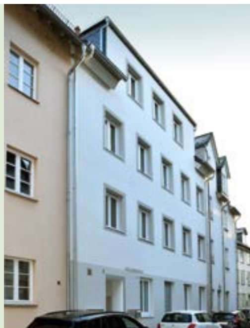
Straßenansicht: Schließung der Baulücke ↓
