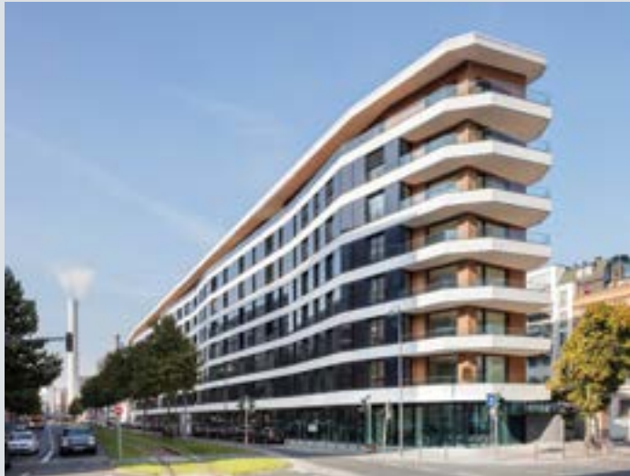
Die 150 Meter lange Photovoltaik-Fassade ↑
