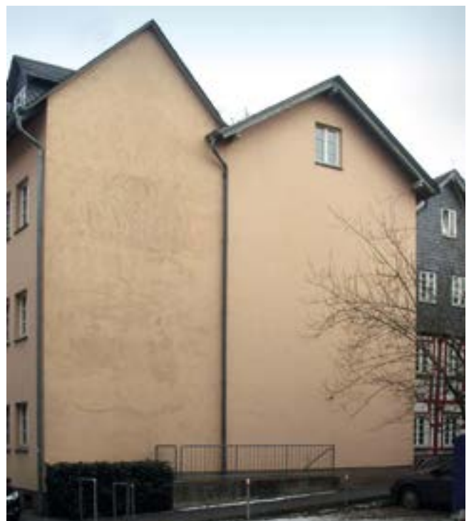
Vorgefundene Situation: Baulücke in der Rahmengasse ↓
