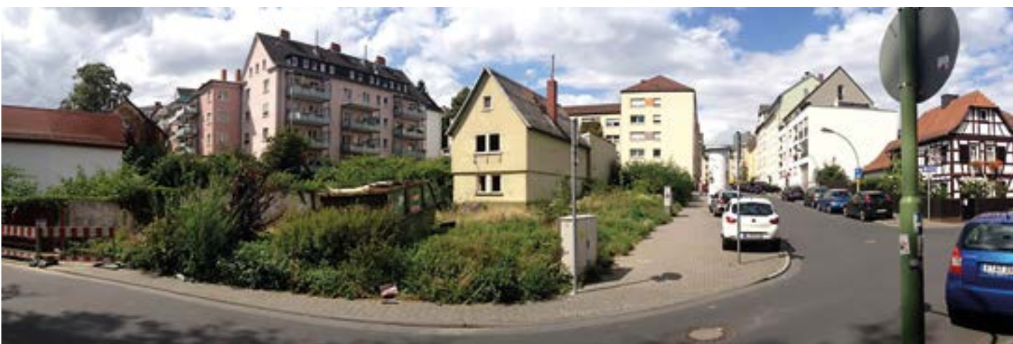
Ursprungszustand: brachliegende Parzellen mit Abbruchhaus ↑
