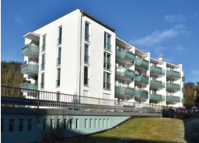
Ansicht von Süden mit bestehender Hochgarage ↑
