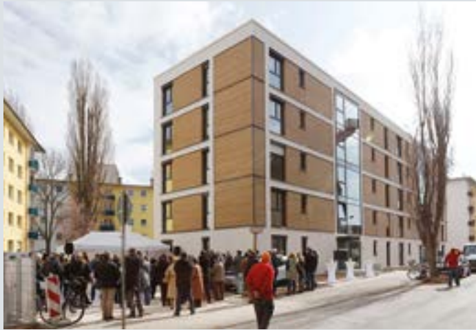
Die Einweihung des Wohnhauses nach nur vier Monaten Bauzeit ↑
